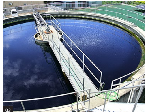
01. 地下水からくみ上げた水は、タンクでろ過して使用される 02. 酸素を送り込みながらバクテリアがいるプールを巡回させる。茶色いのは分解された不純物 03.02 を経て、貯水することで不純物を沈殿させ、上澄みだけを大阪湾へと続く樫井川へ放流する
