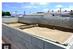
01. 地下水からくみ上げた水は、タンクでろ過して使用される 02. 酸素を送り込みながらバクテリアがいるプールを巡回させる。茶色いのは分解された不純物 03.02 を経て、貯水することで不純物を沈殿させ、上澄みだけを大阪湾へと続く樫井川へ放流する
