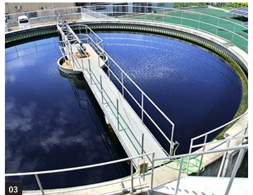
01. 地下水からくみ上げた水は、タンクでろ過して使用される 02. 酸素を送り込みながらバクテリアがいるプールを巡回させる。茶色いのは分解された不純物 03.02 を経て、貯水することで不純物を沈殿させ、上澄みだけを大阪湾へと続く樫井川へ放流する
