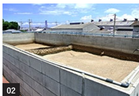
01. 地下水からくみ上げた水は、タンクでろ過して使用される 02. 酸素を送り込みながらバクテリアがいるプールを巡回させる。茶色いのは分解された不純物 03. 02 を経て、貯水することで不純物を沈殿させ、上澄みだけを大阪湾へと続く樫井川へ放流する
