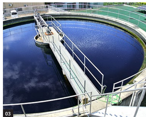
01. 地下水からくみ上げた水は、タンクでろ過して使用される 02. 酸素を送り込みながらバクテリアがいるプールを巡回させる。茶色いのは分解された不純物 03. 02 を経て、貯水することで不純物を沈殿させ、上澄みだけを大阪湾へと続く樫井川へ放流する
